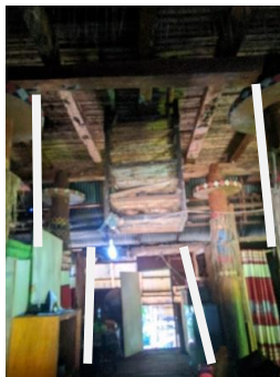
Gambar 3. Empat tiang yang ada pada rumah adat Kampung Tago,o berbentuk garis horizontal
